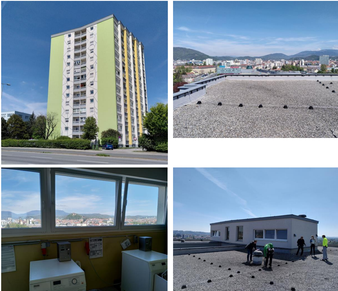
Abb. 9 Fotos der Dach-Begehung am Karlaergürtel 5 (Quelle: Bernhard Hohmann)
